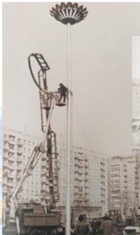
Монтаж мачты у ДК «Газовик» выполнялся по инженерным расчетам Ю.Д. Гаранькина
